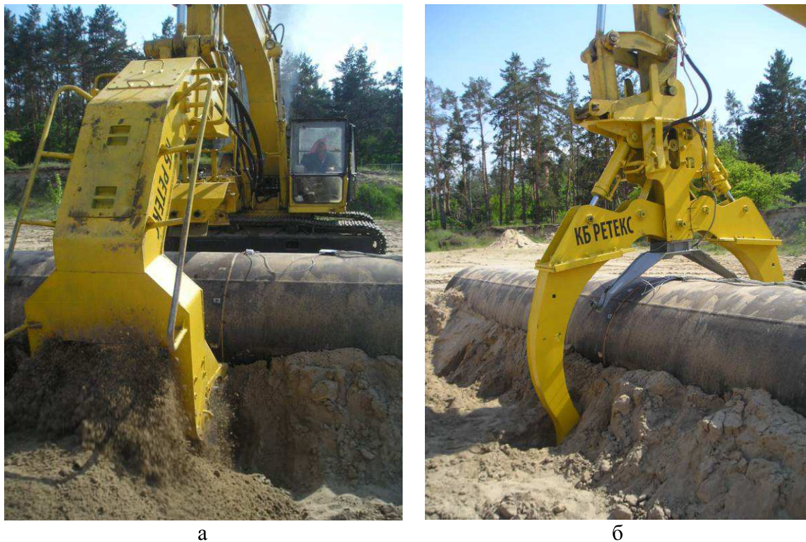
Рис. 1. Випробування обладнання для підкопування та ущільнення ґрунту під трубопроводом: а - підкопування ґрунту під трубопроводом; б - ущільнення засипаного ґрунту під трубопроводом.
