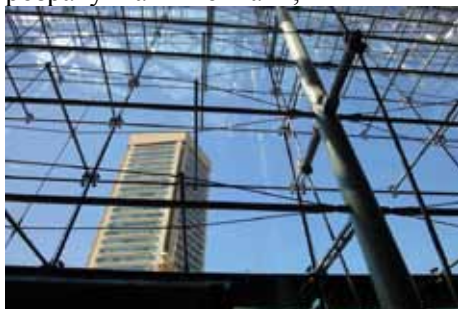
Рис.3 Кріплення спайдера до тросової системи
