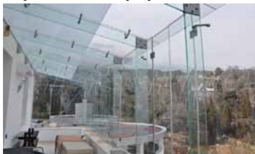
Рис.4 Кріплення спайдера скляних ребер
