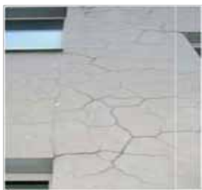
Рис. 9. Разрушение и отслоение штукатурного покрытия от газобетонной кладки [14]
