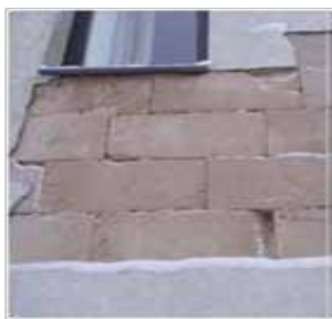
Рис. 9. Разрушение и отслоение штукатурного покрытия от газобетонной кладки [14]
