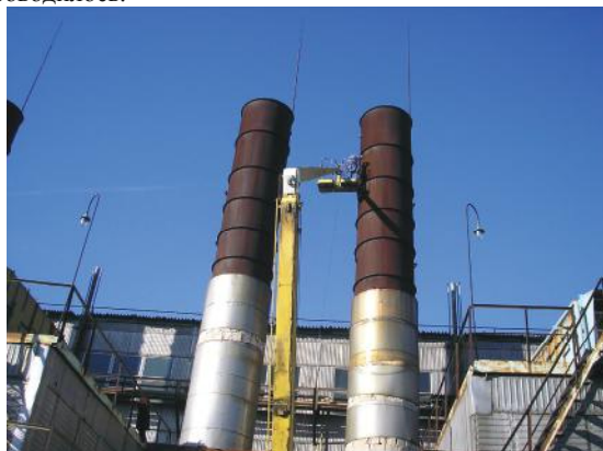
Рис.2. Проведение толщинометрии ствола трубы на отм. 20.00\text{м}
