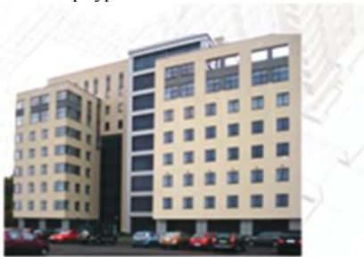
Здание каркасного типа. Основные несущие конструкции выполнены из монолитного железобетона. Колонны - монолитные железобетонные, размером 500x500 мм. Перекрытия и покрытие - монолитный железобетон.
