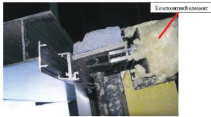
Рис. 4. Елемент жорсткості з композиту в стійки фальш фасаду
