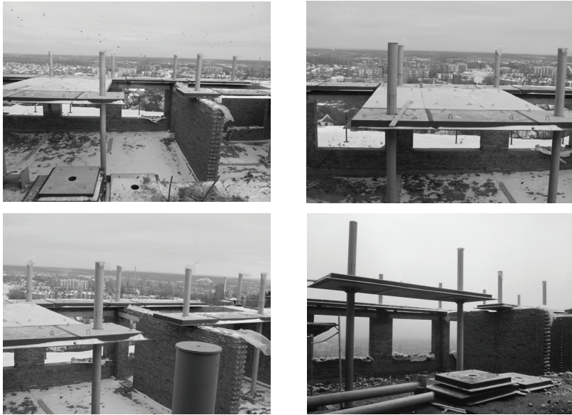
Рис. 3. Монтаж сталеалізобетонного безбалкового перекриття
