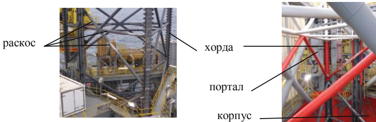
Рис. 5 – Опорная колонна и корпус СПБУ
