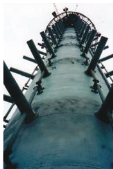
Рис.8. Вид на антенный ствол от отм. + 385.0 м
