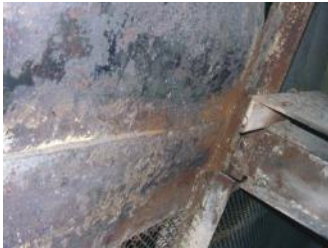
Рис.13. Отм.+ 80.0 м. Диагональная волнообразная деформация стенки балки фидерной шахты
