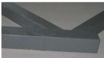
*Рис. 3.6. Стык нижнего пояса стропильной фермы Ф А-Б-6*
