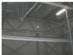
*Рис. 3.4. Торцевые крестовые связи между стойками фахверка по оси 11*
