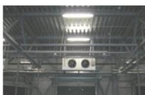
*Рис. 3.9. Подвешенное к прогонам в пролете А-Б технологическое оборудование (охладители)*
