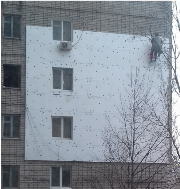
Рис. 4. Утепление фасада / The insulation of facade
