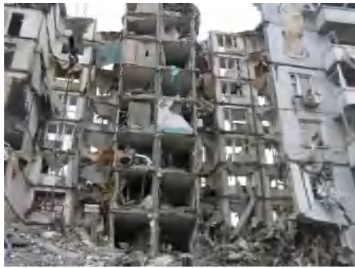
Рис. 1. Наслідки вибуху газу у будинку по вул. Мандриківська, 127 у Дніпропетровську/
