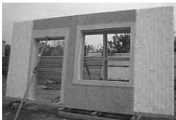
Рис.3. Стеновая панель с декоративным слоем / Wall panel with a decorative layer
