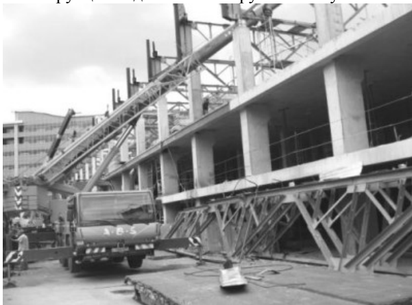
Рис. 2 Реконструкция промышленного здания (демонтаж плит покрытий) / Reconstruction of industrial buildings (dismantling of covering plates)
