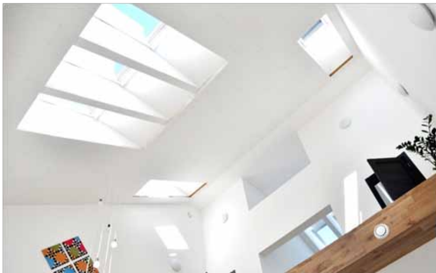
Рис. 5. Основное пространство МК-дома, обеспечивающее накопление пассивного солнечного тепла, естественный свет и проветривание.
