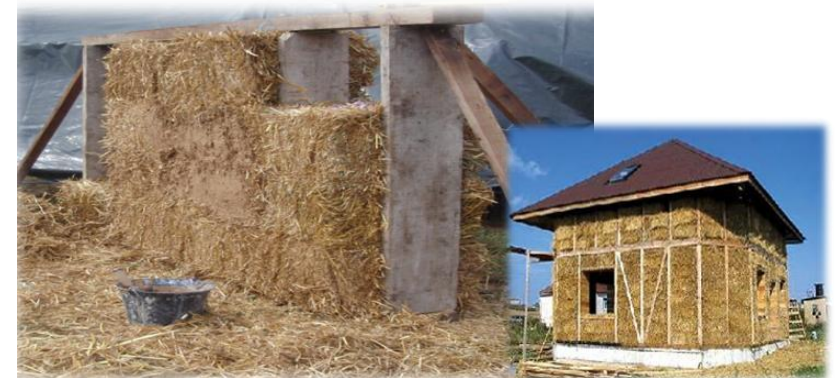
Рис. 1. Використання соломи при зведенні екологічних будинків
