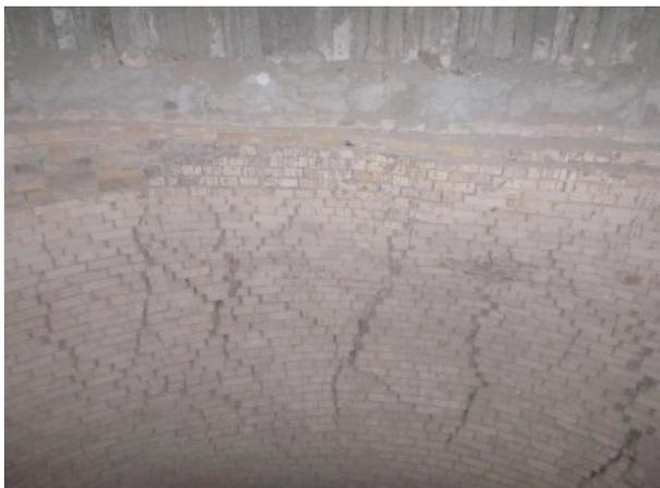
*Рис. 4. Сетка силовых трещин шириной раскрытия до 80мм, выход из плоскости кладки футеровки ствола трубы 1-го яруса с отм. 16.00м до отм. 20.00м.*
