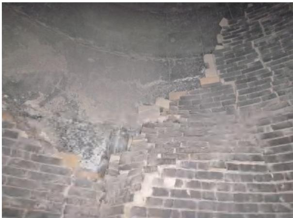
*Рис. 3. Полное разрушение футеровки и теплоизоляции ствола трубы в уровне карниза 7-го яруса.*
