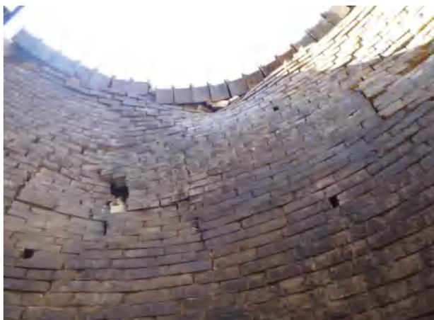
*Рис. 5. Состояние футеровки оголовка трубы 9-го яруса в уровне оголовка.*
