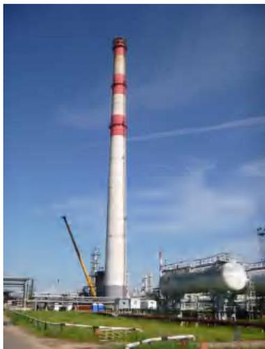
*Рис. 1. Общий вид железобетонной дымовой трубы высотой  $H=120\text{м}$  печей П-601 и П-602 технологической установки ЛЧ 35/11.*
