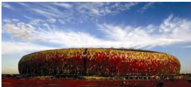
Рис. 6. Футбольный стадион в Йоханнесбурге: Бетон для фасадных элементов, приготовлен в интенсивных смесителях (EIRICH) (Авторское право Corbis Images)
