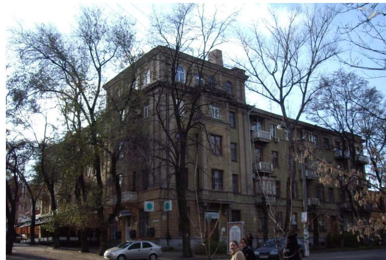
Рис.1. Общий вид здания на фасад со стороны ул. Фучика
