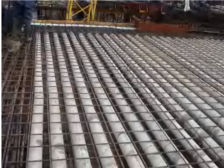
Рис. 3. Пустотообразователи из картонных труб
