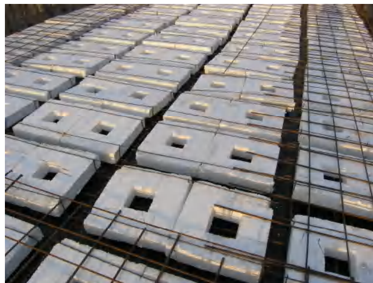
Рис. 2. Пустотообразователи прямоугольного сечения из пенополистирола
