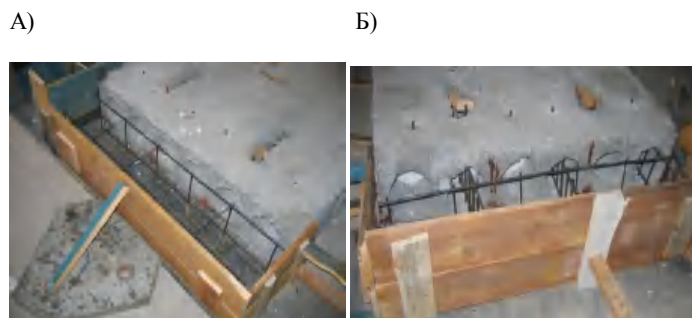
Рис. 2.Подготовительные работы перед замоноличивание, шпонок. А) неармированная шпонка;Б) армированная шпонка
