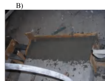
Рис. 3. Замоноличивание ригеля.
