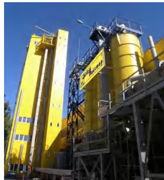
Рис. 1. Вертикальна лінія з виробництва будівельних сумішей „БудМайстер”, м. Павлоград.
