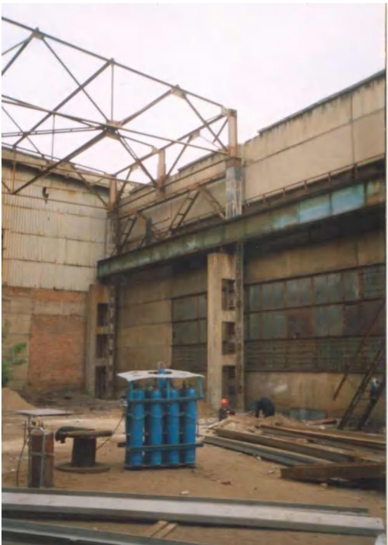
Рис. 5. Усиление стальными обоймами и наращивание железобетонных колонн
