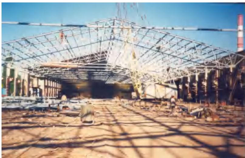
Рис. 3. Новые несущие конструкции покрытия цеха пролетом 45 м после реконструкции
