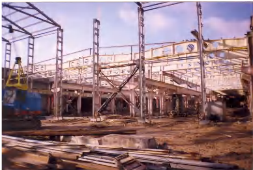
Рис. 2. Существующий железобетонный каркас цеха до реконструкции
