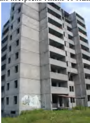
Рис. 5 Общий вид 10-этажного здания в Бородинском микрорайоне г. Запорожье
