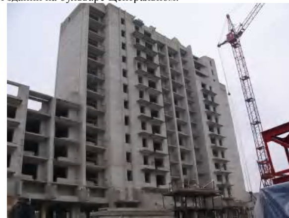
Рис. 1. Общий вид обследуемого здания
