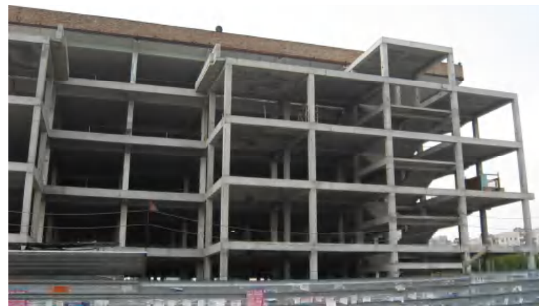
Рис.1. Железобетонный монолитный каркас реконструируемого здания
