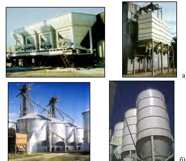
Рис. 1. Ємності для сипучих матеріалів: а) – бункерні; б) - силосні
