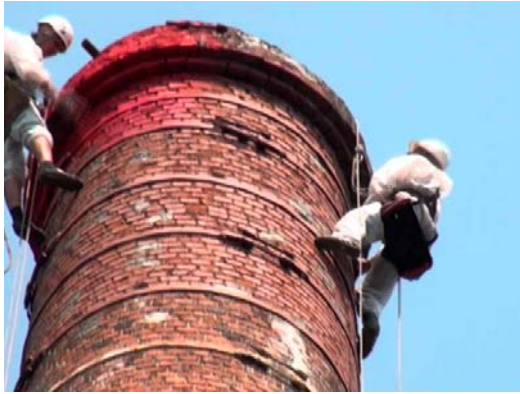
Рис. 3. Обстеження труби альпіністами / Inspection of pipe by alpinists
