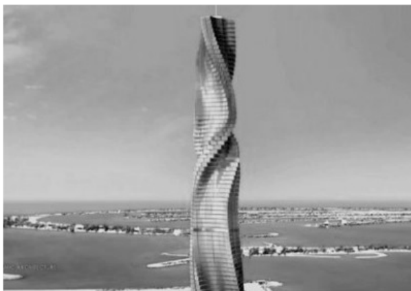
Рис. 1. Строительство первого в мире вращающегося небоскрёба в Дубае (Фото: Youtube) / Construction of the world's first rotating skyscraper in Dubai
