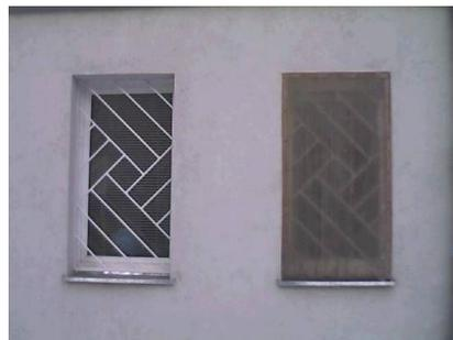
*Рис. 1. Фрагмент ограждающей конструкции с однорамным оконным блоком и с установкой дополнительной оконной рамы из поликарбоната (4 мм)/*
