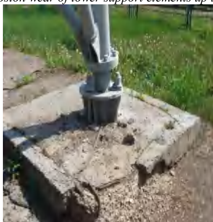
Рис 10. Потеря устойчивости фасонки опорного раскоса башни /
